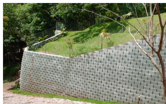
Acabamento da face com blocos segmentados.
