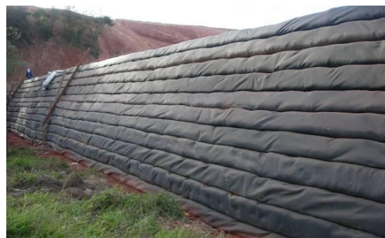
Vista frontal da face durante a construção.
