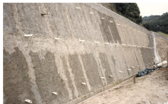
Acabamento da face com concreto projetado.
