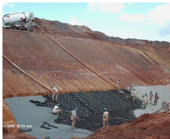
Concretagem das geocélulas FORTCELL por bombeamento.
