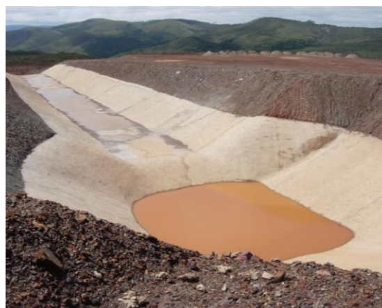
Aparência final do canal revestido com geocélulas FORTCELL.
