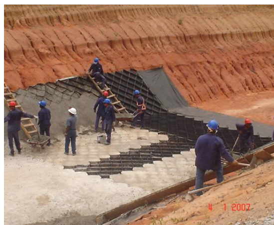
Detalhe da concretagem das geocélulas FORTCELL.
