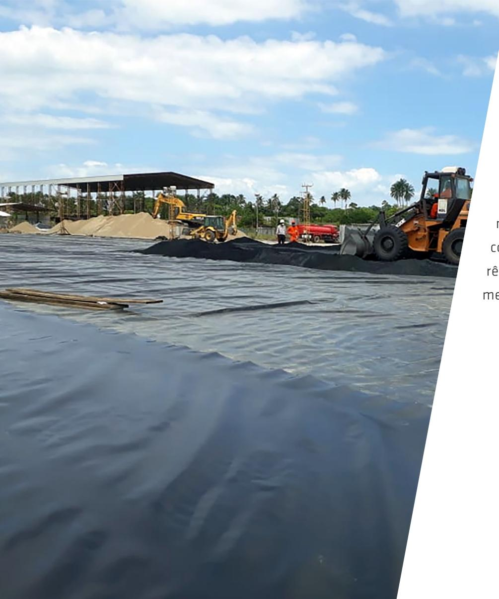
A FortLiner Geomembrana é fabricada pelo processo matriz plana e tem como principal matéria-prima o polietileno de alta densidade (PEAD), além da adição de negro de fumo. Sua principal função é atuar como barreira de controle de fluxo em decorrência de seu baixíssimo coeficiente de permeabilidade.
